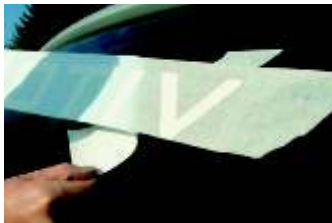
5. Motiv einseitig anheben, Silikonpapier langsam ca. 10cm abziehen & Motiv an zweiter Markierung unter Spannung ausrichten
